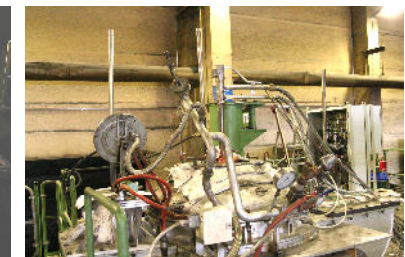
ND-Ofen 6,2 t/Inhalt Sintern/Aufheizen bis auf 1550°C mit unserer Oxy-Fuel-Brenneranlage nach vorgegebener Sinterkurve.
